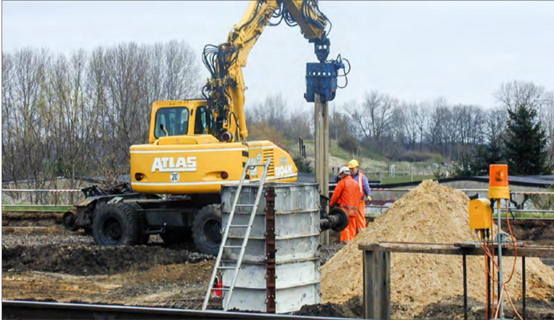
Abbildung 21: Auch auf Baustellen ist grundsätzlich mit Arbeitsmitteln und Arbeitsgegenständen, zum Beispiel Leitern, Schalungen, ein Mindestabstand zur Gleismitte von 2,2 m beziehungsweise bei Fahrgeschwindigkeiten über 30 km/h von 2,4 m einzuhalten.
