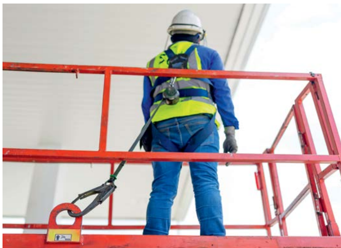
Rückhaltesystem bei Arbeiten mit einer Teleskop-Hubarbeitsbühne
