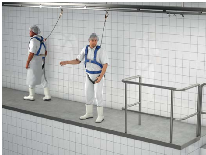
Rückhaltesystem mit beweglicher Führung bei Arbeiten an Absturzkanten
