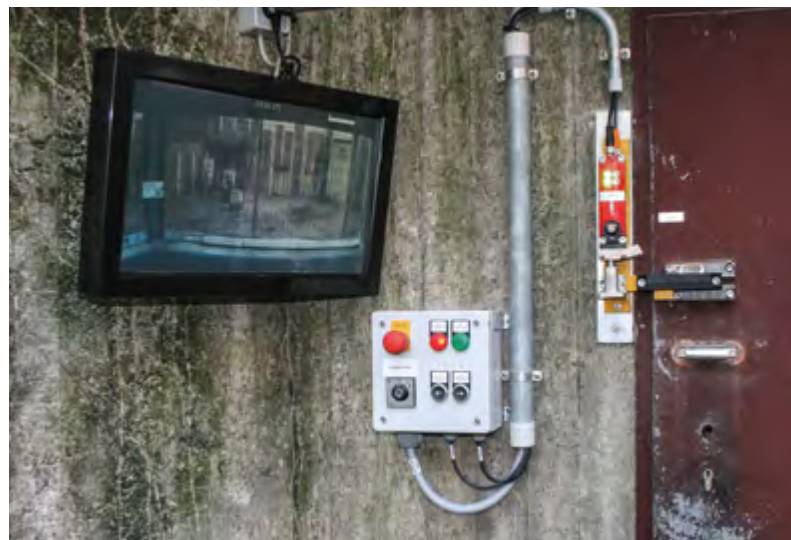
Abbildung 22: Verriegelter Zugang mit Zuhaltung zu einem Außengehege.
