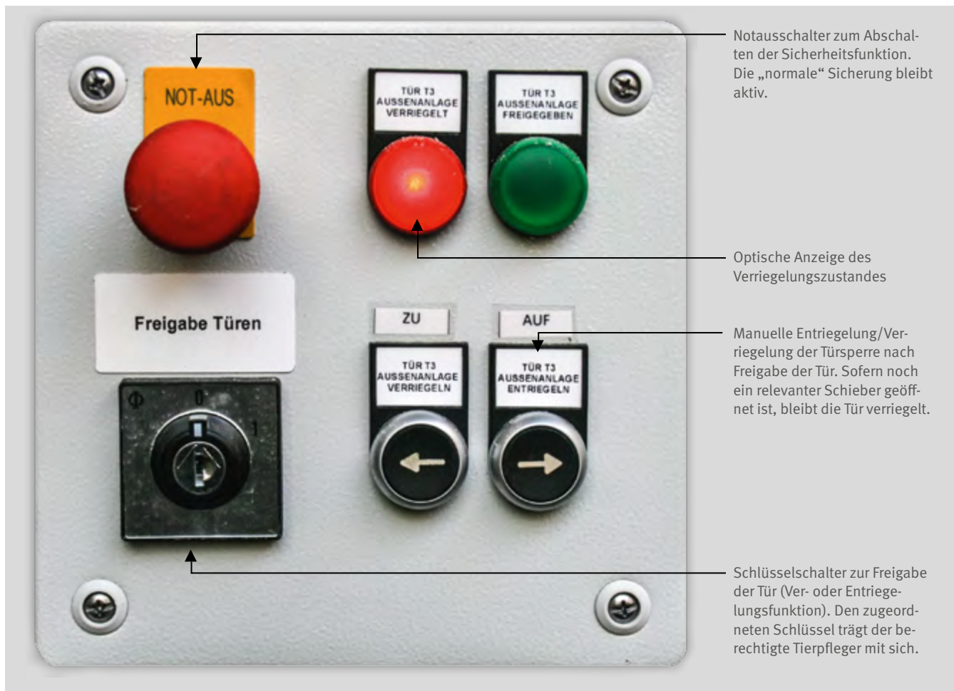
Abbildung 24: Bedieneinheit am Zugang des Außengeheges
