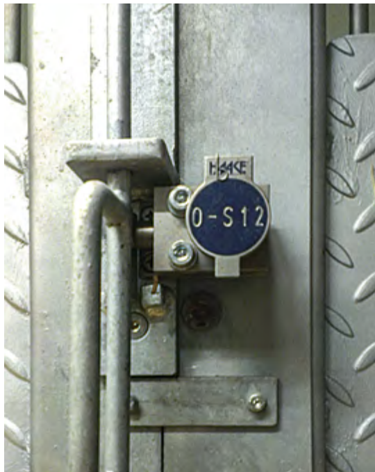
Abbildung 36: Zuhaltung der Schieberbetätigung
