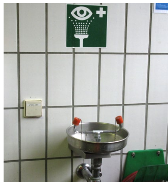
Eine Augendusche mit Trinkwasseranschluss ermöglicht es, die Augen effektiv spülen zu können.
