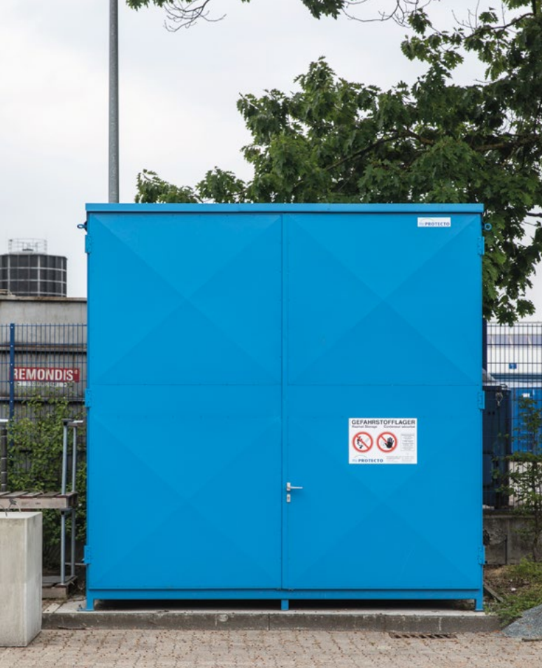
Abbildung 16: Gefahrstofflager für unbeschädigte (i. O.) HV-Batterien
