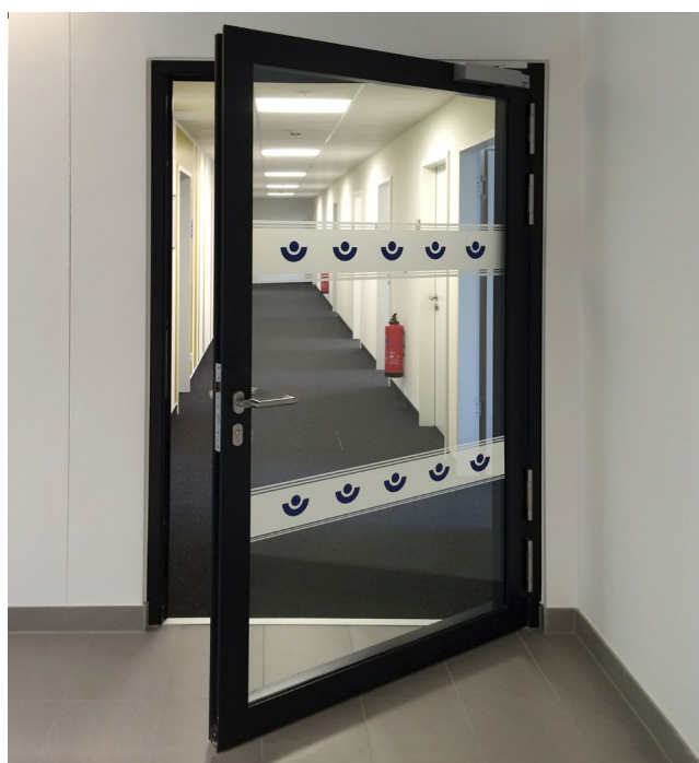
Abb. 3 Glasfläche mit barrierefreier Kennzeichnung in Augenhöhe
