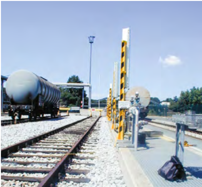
Abbildung 9: Die Engstelle in dieser Verladeanlage ist vorschriftsmäßig gekennzeichnet. Beim Befahren des Gleises darf sich niemand in der Engstelle aufhalten. Nach dieser Seite darf sich nicht aus dem Triebfahrzeug hinausgelehnt werden.
