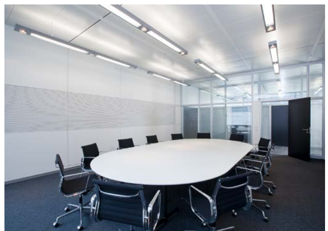
Abb. 19 Schallabsorbierende Wandverkleidung
