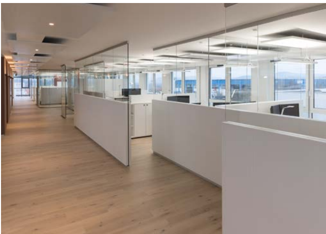
Abb. 20 Schalldämmende und -absorbierende Trennwände
