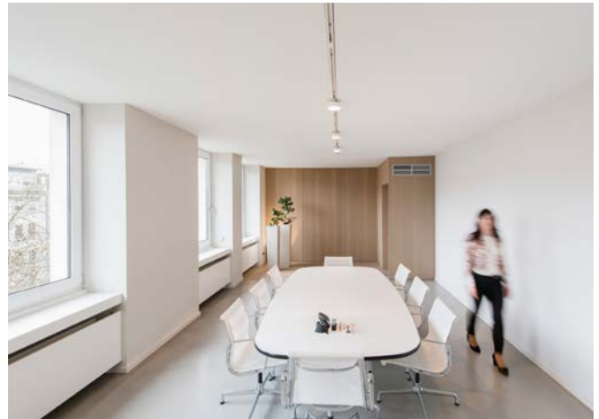
Abb. 13 Schallabsorbierende Akustikdecke ohne Fugen
