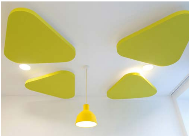
Abb. 16 Schallabsorbierende Deckensegel
