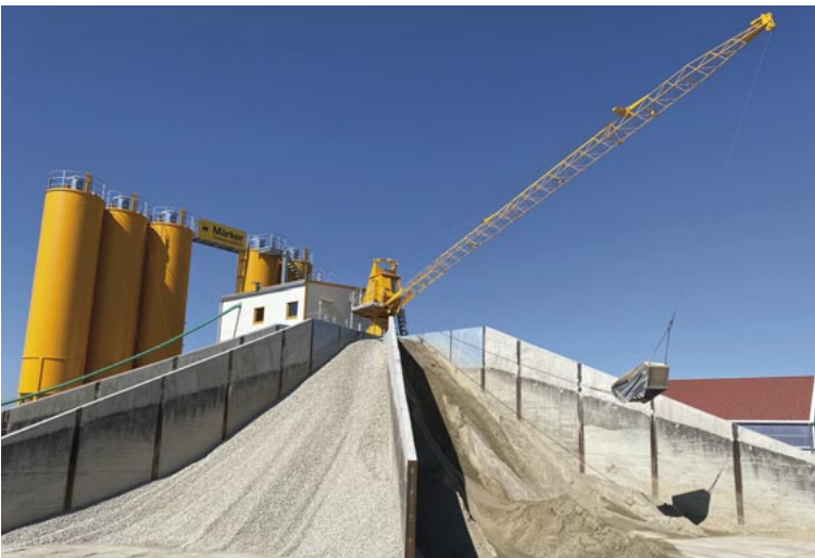
Abbildung oben: Schrapperanlage mit Sternbunker eines Betonmischwerks im laufenden Betrieb
