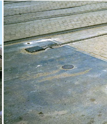
Abbildung 35: Das geschlossene Zugseil dieser Seilzuganlage ist so versenkt angebracht, dass es keine Stolperstelle bildet.
