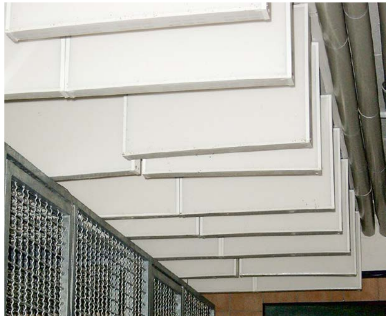
Abbildung 15: Im Hundehaus über den Gehegen: Vertikal angebrachte Lamellen aus Mineralfasern als Schallschutz
