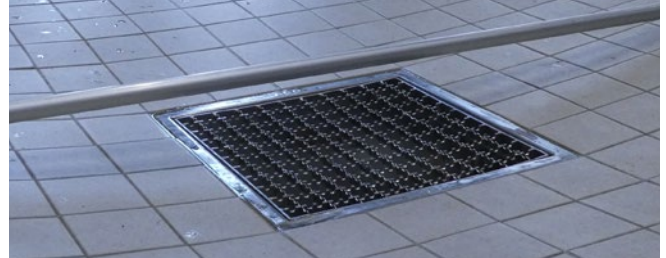
Abb. 37 Rutschfeste Ablauföffnung mit ausreichendem Gefälle
