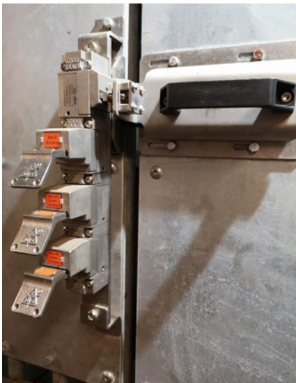
Abb. 13 Schlüsseltransfersystem, Zuhaltung an einer Gehegetür
