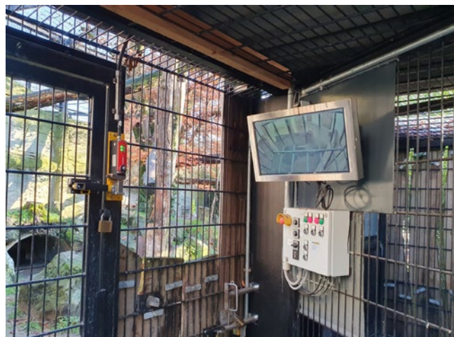
Abb. 15 Verriegelung einer Gehegetür durch eine Sicherheits-SPS
