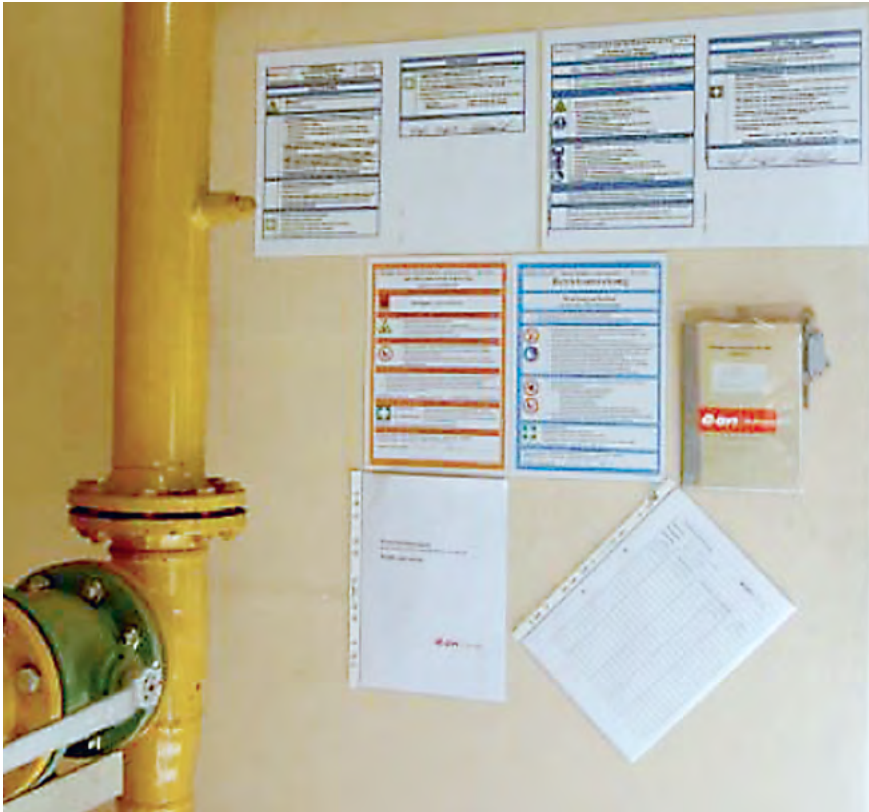
Abbildung 8: Die Betriebsanweisung hängt an der Notabsperrramatur aus
