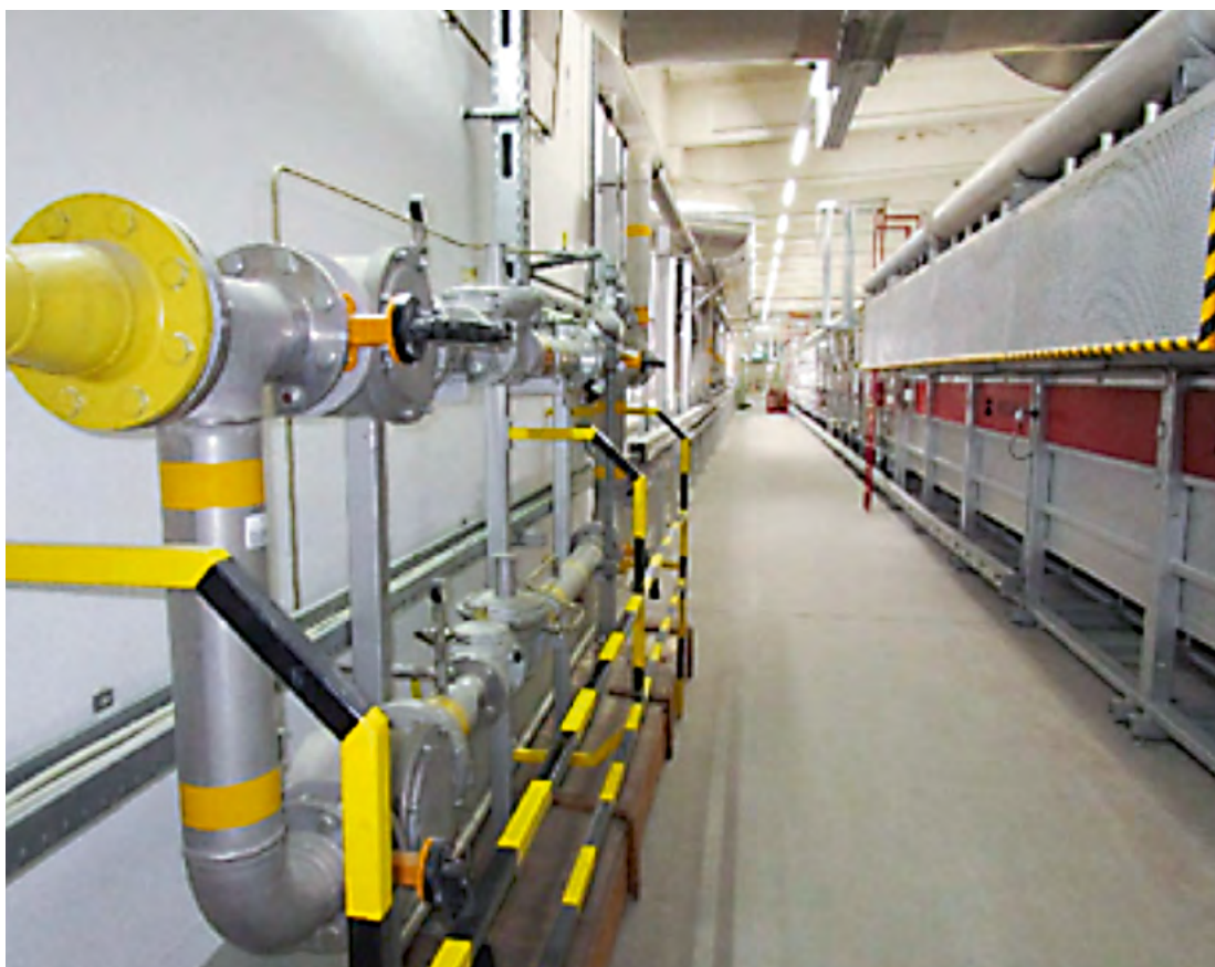
Abbildung 5: Sicherheits- und Regelstrecke an einer Thermopro- zessanlage
