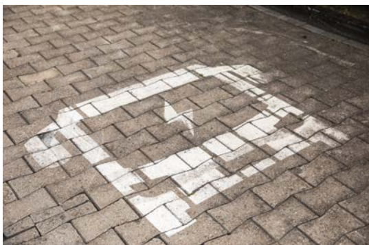
Abbildung 16: Kennzeichnung gesicherte Ruhefläche
