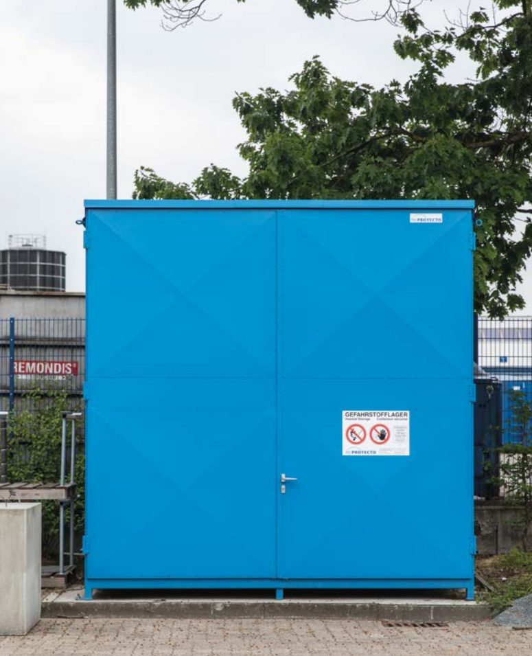
Abbildung 18: Gefahrstofflager für unbeschädigte (i. O.) HV-Batterien
