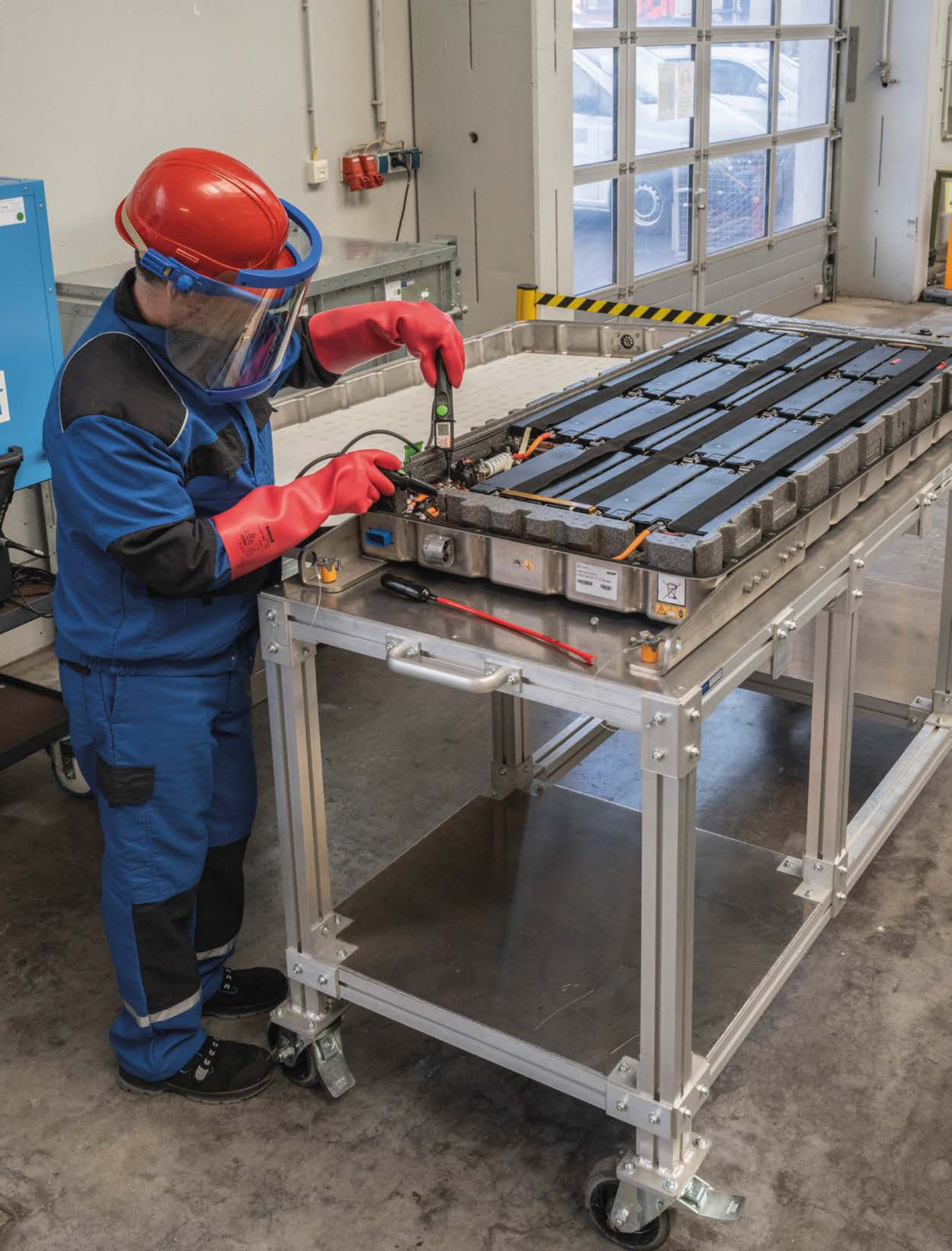
Abbildung 2: Arbeiten an einer Traktionsbatterie
